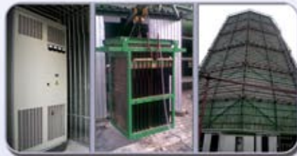
Монтаж установки ЭПСЭ, производительностью 5000 м³/ч на оборотном цикле ПрАО Донецксталь-«МЗ»
