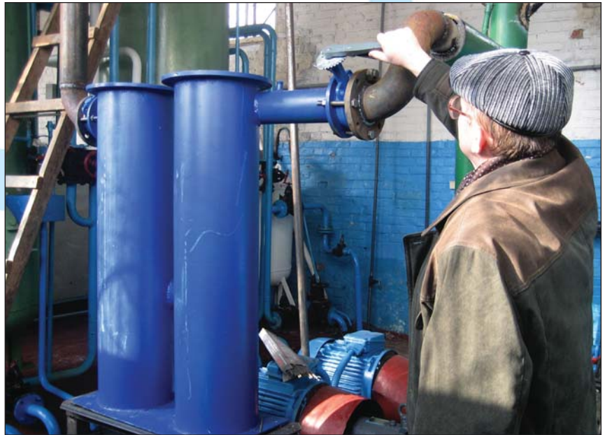
Рис. 4. Монтаж установки БАУ на котельной спортивного комплекса "Локомотив", г. Донецк
